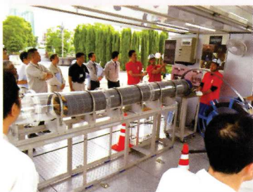
写真-1 たるみ部分の製管 を実演
